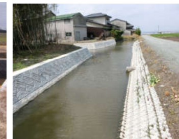
クリーク護岸完成
