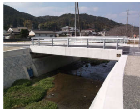
道路拡幅による橋梁架替
