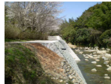
河川改修完成
