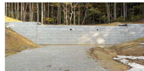
砂防堰堤体工事中
