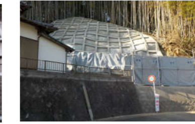
法面保護 (場所打ち法枠)
