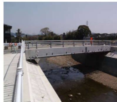
河川改修による橋梁架替
