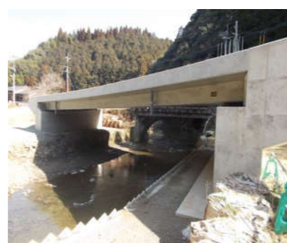
道路拡幅による橋梁架替
