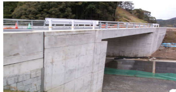
国道バイパス新設に伴う道路橋完成
