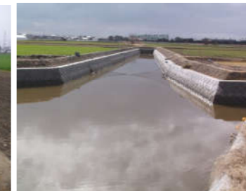
クリーク護岸完成
