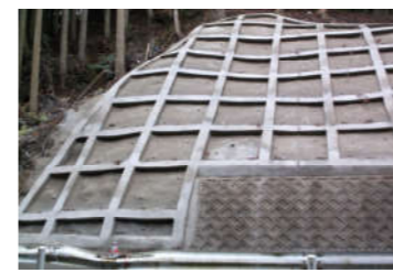
法面保護 (場所打ち法枠)
