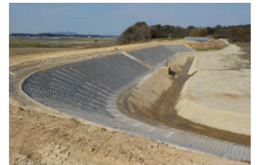
ため池堤体工事中
