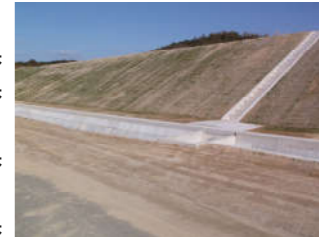
ため池堤体完成
