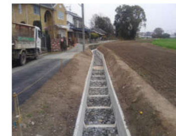
農業用水路工事中
